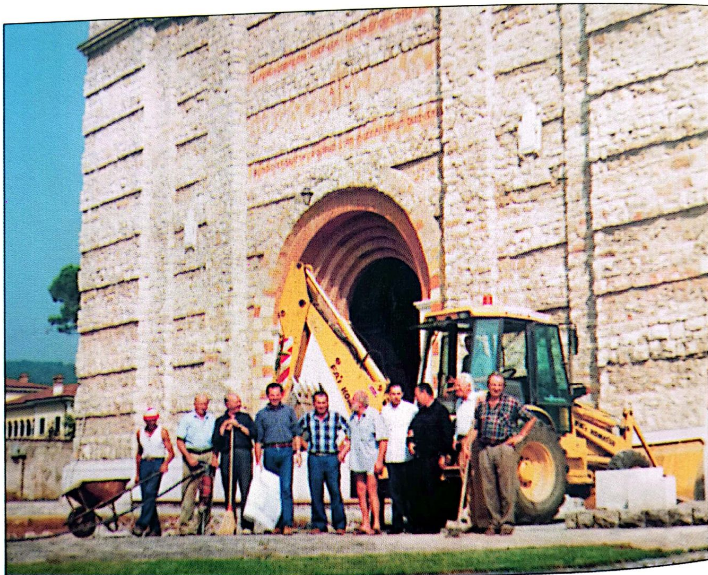
Il 2 Novembre 1999 iniziano i lavori
