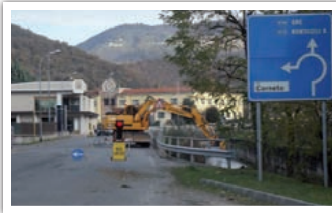
Lavori pulizia Gandovere località Cantarana
