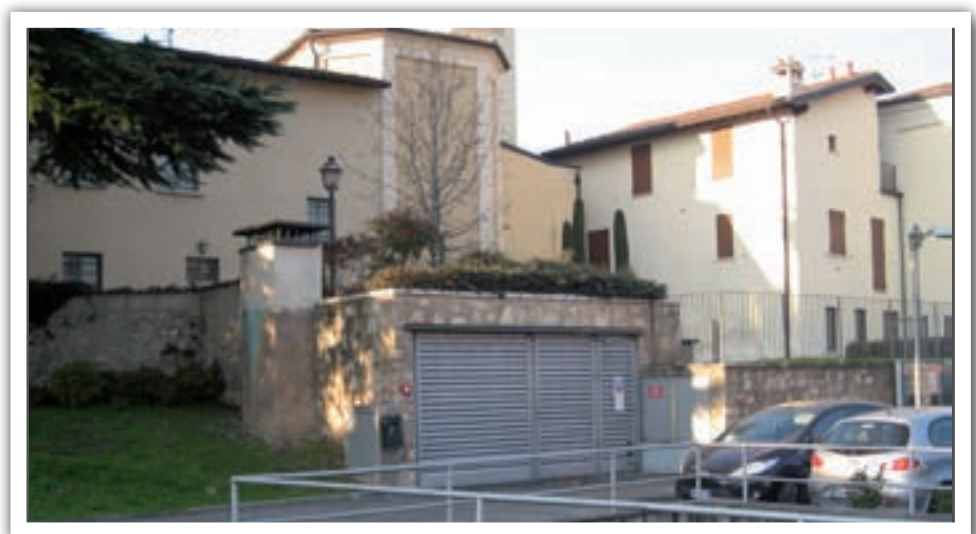
Centrale Termica San Salvatore
